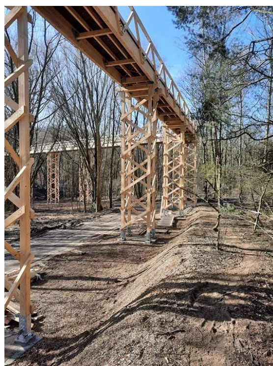
Prace budowlane - ścieżka w koronach drzew (fot. Ł. Polakowski)
