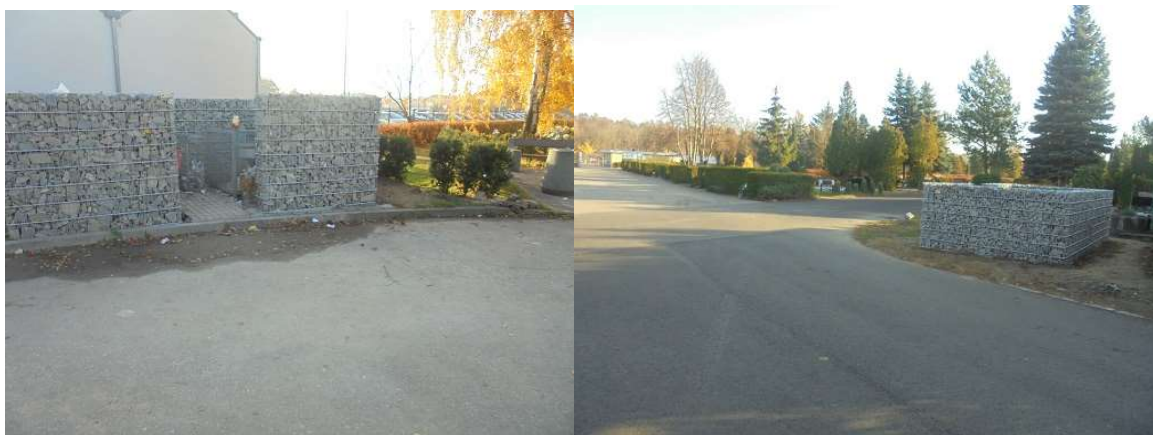
Zabudowa gabionowa koszy na odpady na Junikowie Źródło: Archiwum UK
